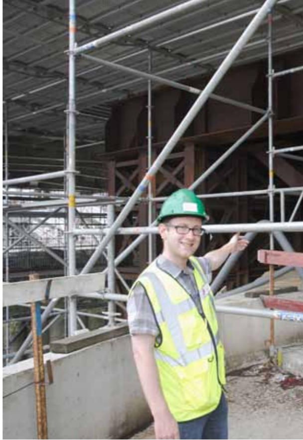
Engineer Alex Roelens in representation of the builder-owner, the SNCB Group, showed Robert Mehl the construction area at Mons. Dipl.-Ing. Alex Roelens als Vertreter des Bauherren, der SNCB Group, hat Fachautor Robert Mehl über die Baustelle geführt.
