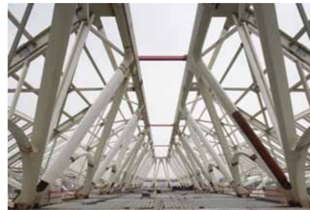
The construction of the hall in structural work. In the background the rounding of the east choir, which protrude beyond the transversal tracks. Die Hallenkonstruktion im Rohbau. Im Hintergrund die Rundung des östlichen Chores, die über die querlaufenden Gleise hinausragt.
