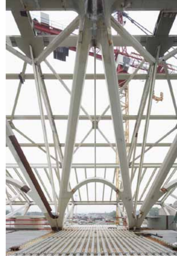
The top of these lateral bay must still be welded with the upper belt, which runs to the end. Ein seitliches Joch, dessen Spitze noch mit dem durchlaufenden Obergurt verschweißt werden muss.
