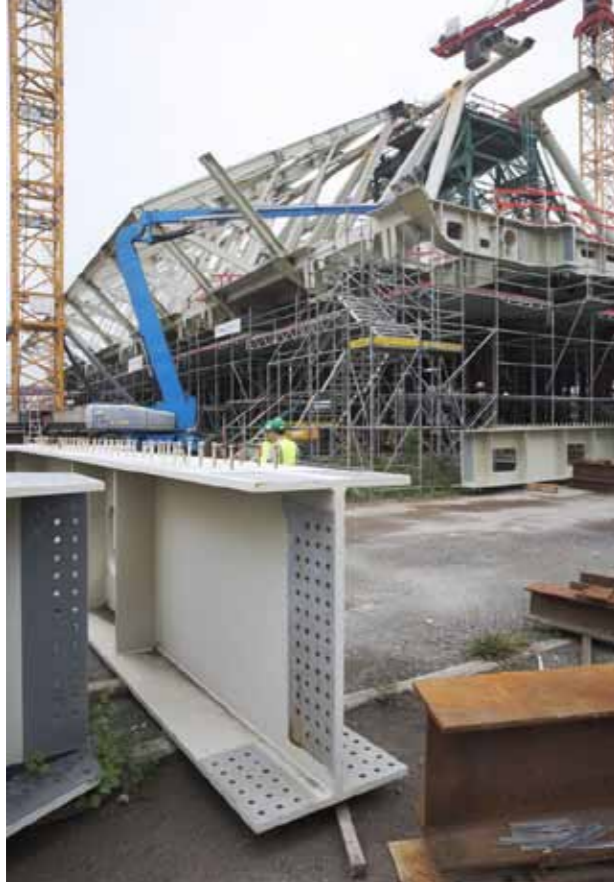
With a crane and an automated crane with an extra long arm, the building components are lifted into their intended position. Stahlbauteile werden mit einem Baukran und einem diesen unterstützenden Autokran mit extra langem Arm an die vorgesehene Stelle gehoben.
