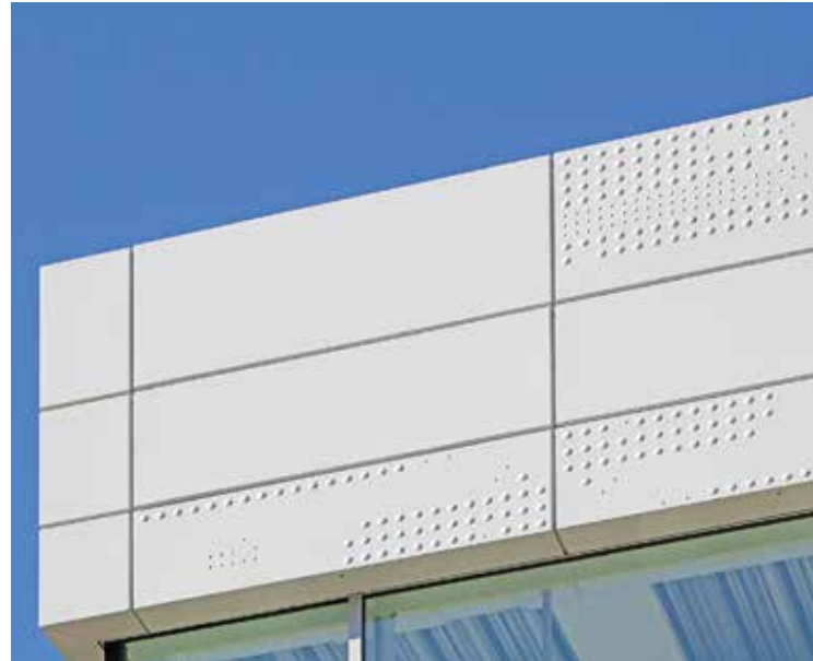
Die komplexe Alufassade von Het Platform in Utrecht wurde mit der Software HiCAD umgesetzt.
