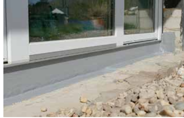
Fertige, bodentiefe Fensterabdichtung mit dem Soudatight WP.
